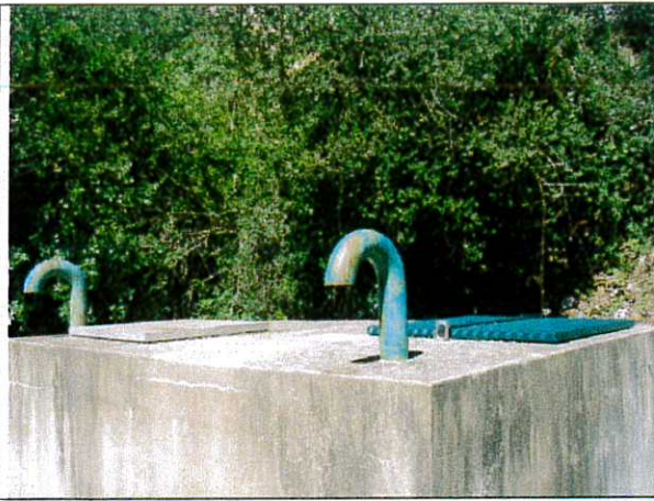
Ouvrage de protection du forage
