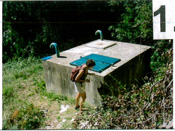
Ouvrage de protection du forage
